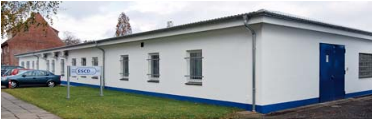
Neues Produktionsgebäude von ESCD in Brunsbüttel
